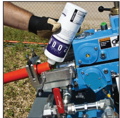
Figure 38. Pour Lube into Conduit
