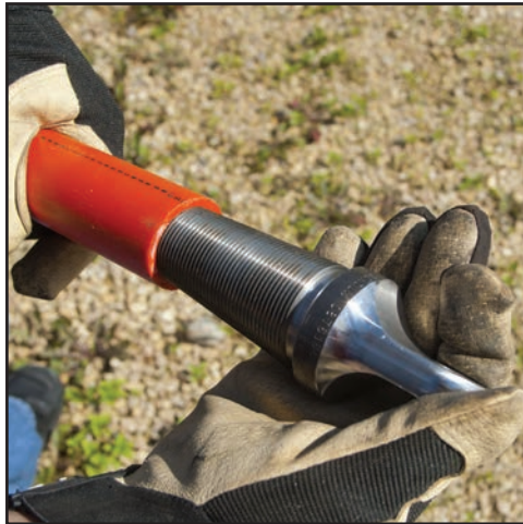
Figure 28. Installing Conduit Pulling Eye
